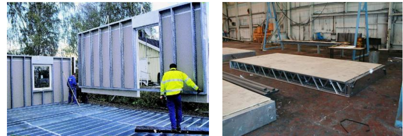
Рис.2. Панели и перекрытия из ЛСТК, произведенные в заводских условиях
