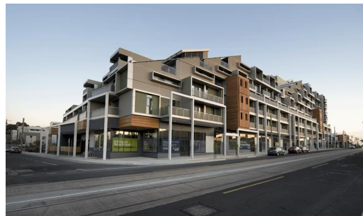
Рис.5. Пример жилого здания, построенного по технологии ЛСТК. Нижний этаж – торговые помещения (Европа).
